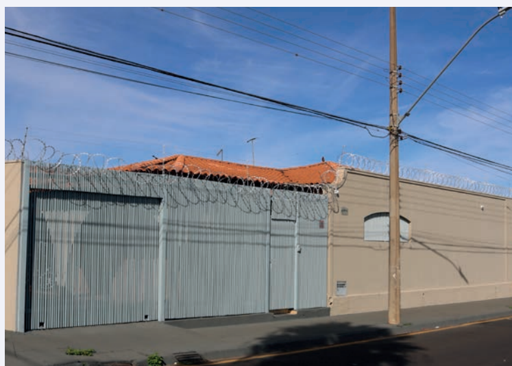
Sede do Sindicato com recente pintura, e em breve nova placa de identificação será instalada
